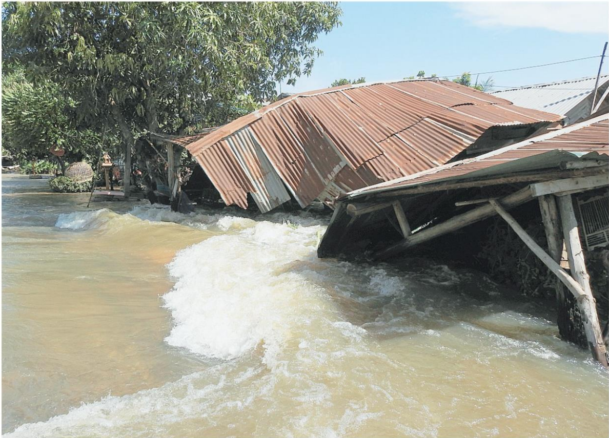
▲ ชัดบ้านพัง สภาพบ้านเลขที่ 144/4 บ้านทางคลอง หมู่ 5 ต.บ้านกล้วย อ.เมืองสุโขทัย ถูกกระแสน้ำไหลแรงพัดเอากระสอบทรายไปกระแทกตัวบ้านจนพังถล่มทั้งหลัง ในพื้นที่ยังมีมวลน้ำที่ล้นจากอ่างเก็บน้ำแม่มอก จ.ลำปาง ไหลเข้ามาอย่างต่อเนื่องและเป็นพื้นที่รับน้ำจากทุ่งทะเลหลวงด้วย.
